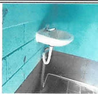
Foto 2: Mejoramiento de instalaciones potables y colocacion de lavamanos nuevos
