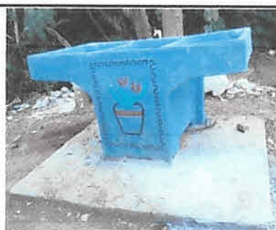
Foto 4: mejoramiento de instalaciones potables y pila nueva.
