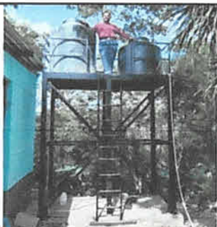
Foto 3: fabricación de pedestal metalico para colocación de tinacos
