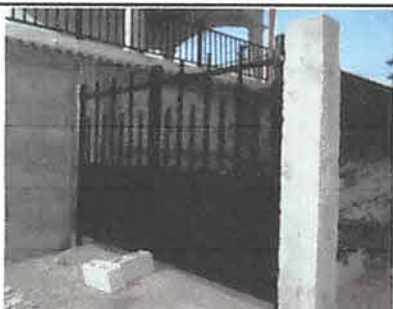
Foto 5: mejoramiento e instalación de porton Principal
