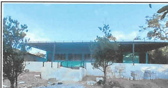
Foto 6: mejoramiento de cimentación del patio más construcción de ingresos por medio de gradas y rampas y pasamanos.
